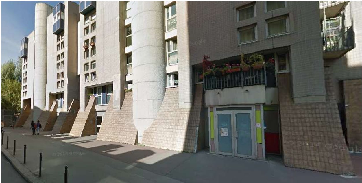
Rue de Lagny, Paris
